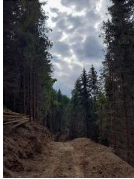
Nová zväžnica budovaná pásovým bagrom
