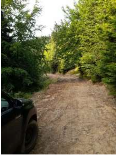
Poškodené teleso cesty po úprave strojom
