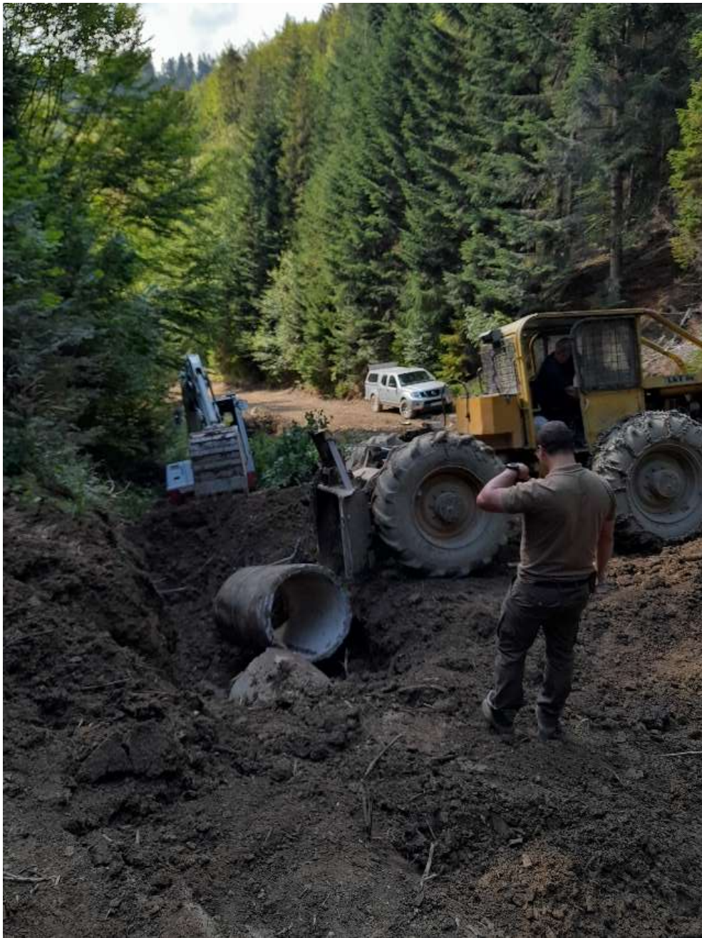
Osádzanie rúr v náročnom teréne, nedostupnom pre bežné mechanizmy.
