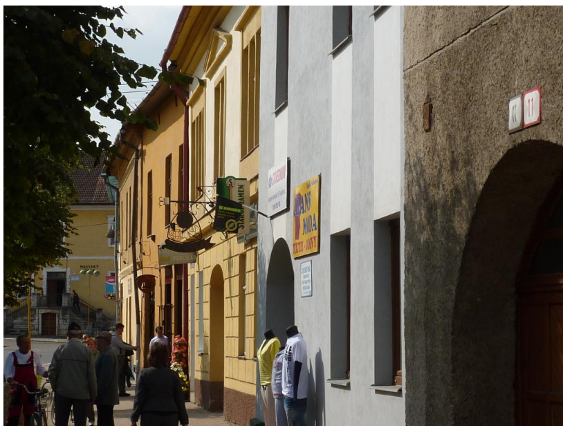
355. Chránený pohľad č. 11 na severný front námestia – detail
