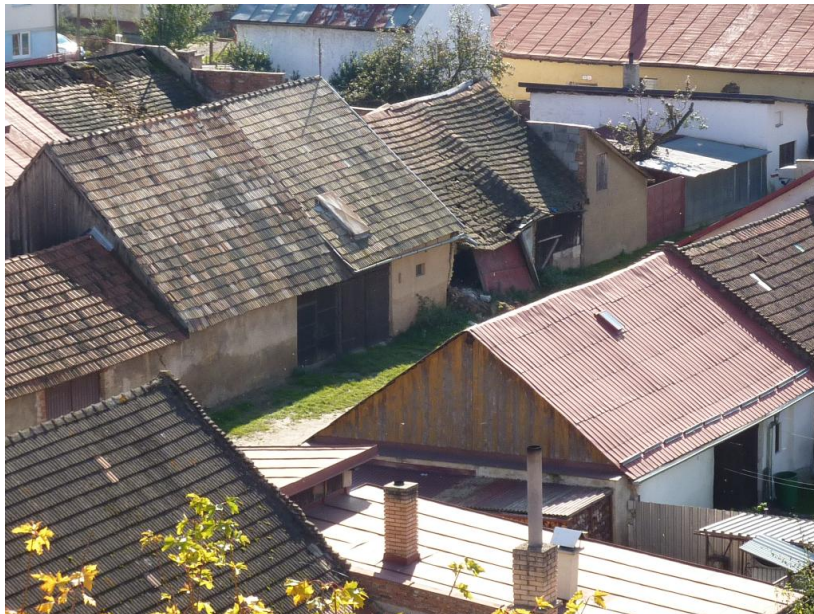
375. Chránený pohľad č. 35 z balkóna kláštorného kostola Glos 2010
