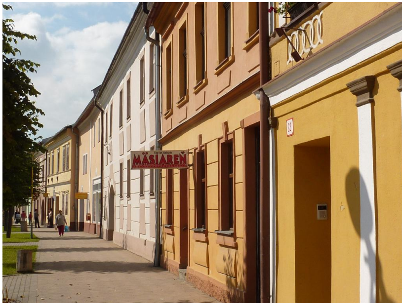
354. Chránený pohľad č. 13 na severný front domov námestia
