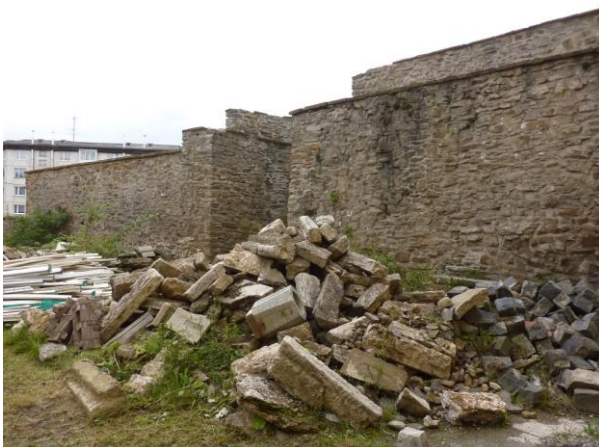
311. Hradby pri radnici – interiér Glos 2010
