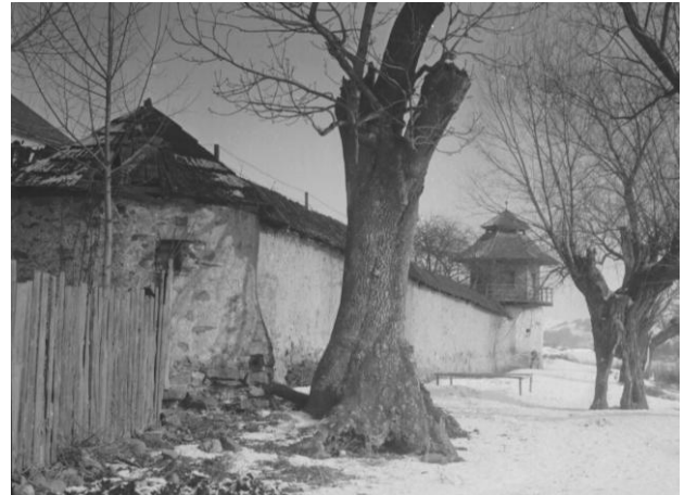
320. JV opevnenie kláštora Archív KPÚ Prešov
