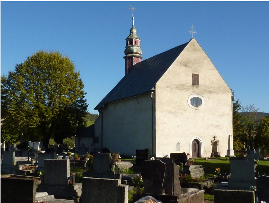
339. Kaplnka sv. Anny na cintoríne NKP zo severozápadu
