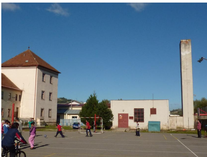
201. Pohľad na JV vežu kláštora a novostavbu kotolne
