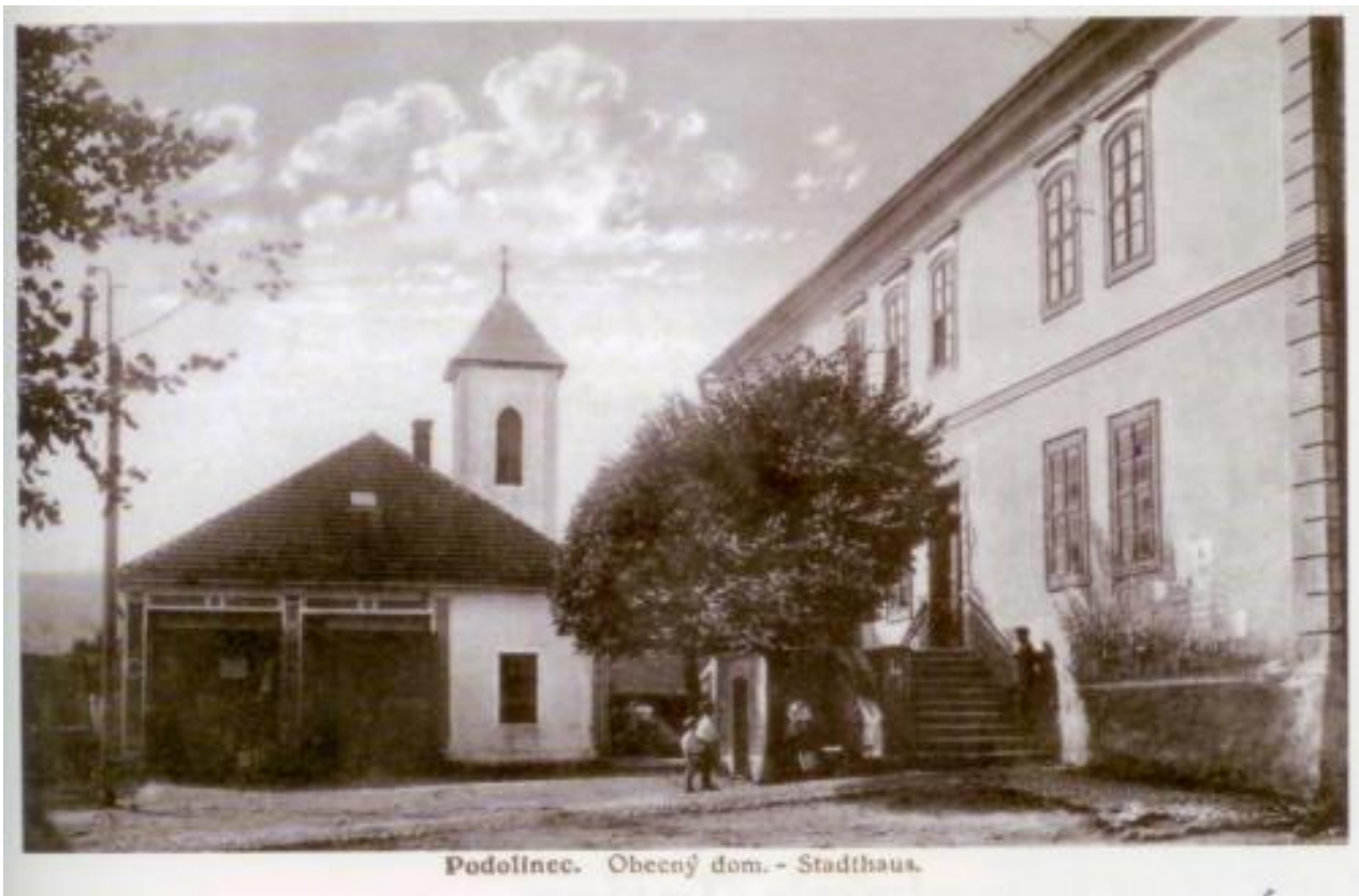
36b. Pohľad na požiarnu zbrojnicu a radnicu
