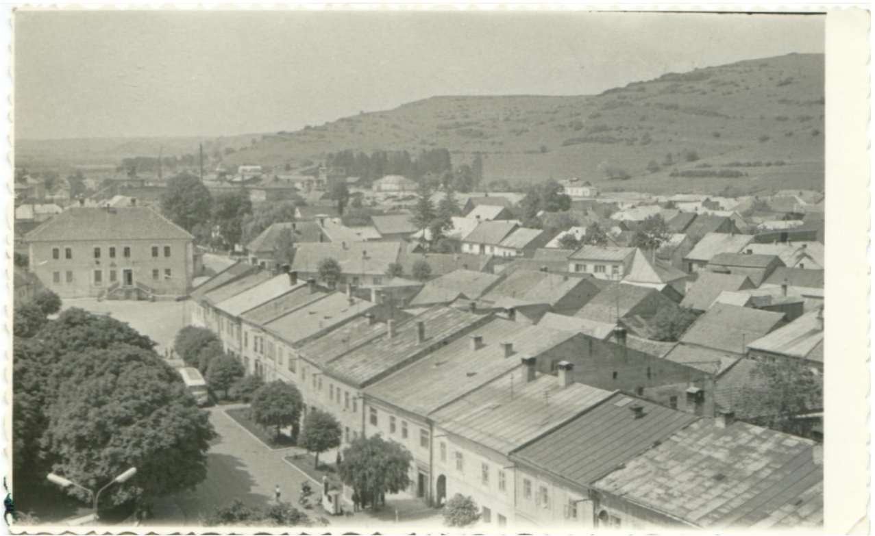
25. Pohľad na západnú časť mesta z veže farského kostola
