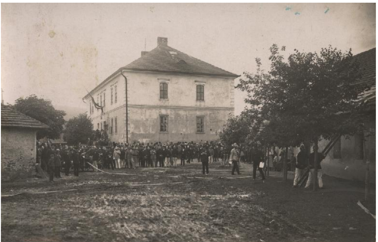
32. Severný pohľad na radnicu (požiar priľahlej budovy)
