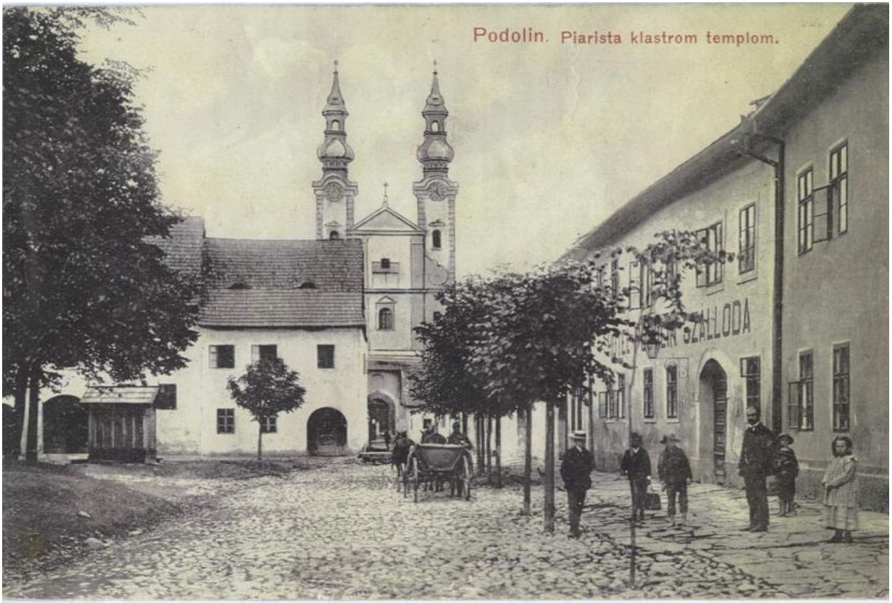
37. Pohľad na východnú časť námestia s kláštorom
