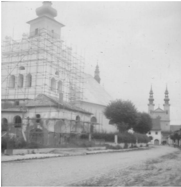
51. Pohľad na námestie počas opravy exteriéru zvonice Archív KPÚ Prešov Markuš 1962 č. neg. 3397
